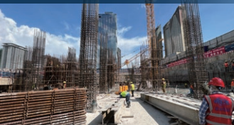
Rebar Structure Construction 柱子鋼筋搭建工程
