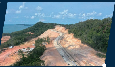
Sihanoukville Road Rehabilitation 西哈努克路修復工作
